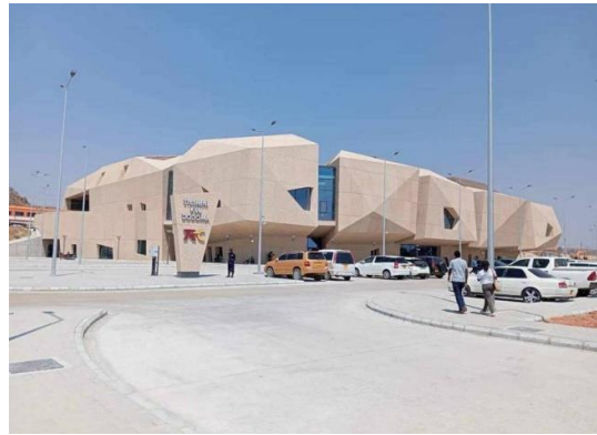
写真2-5 新設されたSGR鉄道ドマ駅
