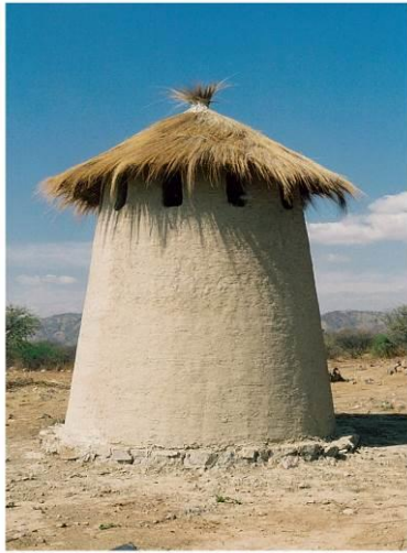
写真2-5 コタパチ村に復元されたトウモロコシ用の 日干し煉瓦造の土蔵
