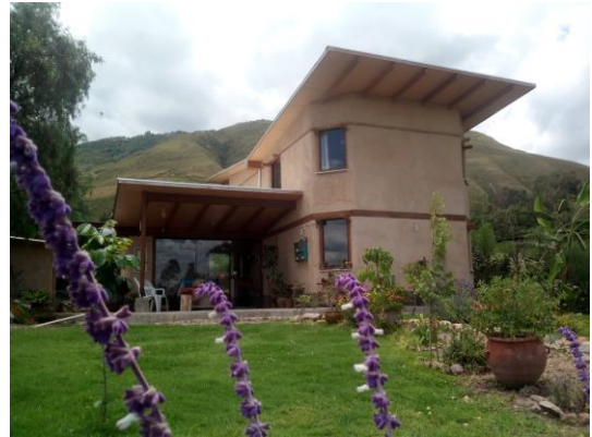
写真2-9 土塗り壁で仕上げ日干し煉瓦の住まい
