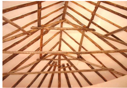
写真2-3 サンティアゴ・コルケ氏によって施工された石膏プaster塗り天井
