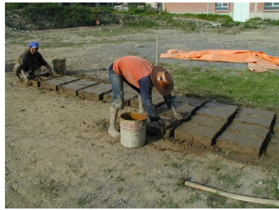
写真2-6 12000個の日干し煉瓦づくりの作業風景
