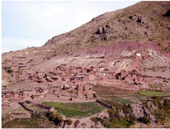
写真2-2 学び舎3棟目が建設されたコチ・バケリーヤ村を見渡す
