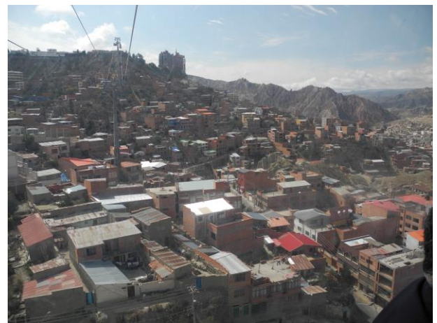
写真3-4 錆びたトタン屋根の多い首都ラパスの風景
