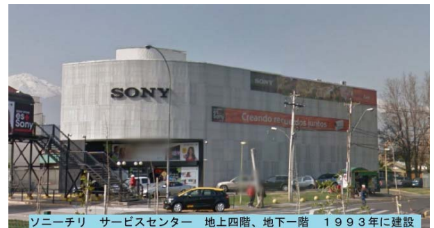
写真4-1 このビルには最新建設技術が使われており地震国チリでも絶対に倒壊しません
