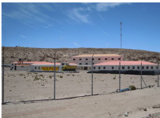
パイロットプラントの外観
