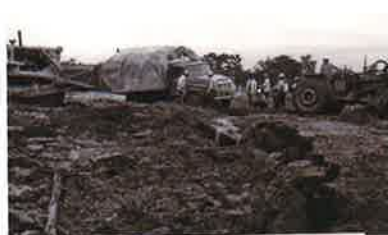
サンフアン移住地への道路開通工事
